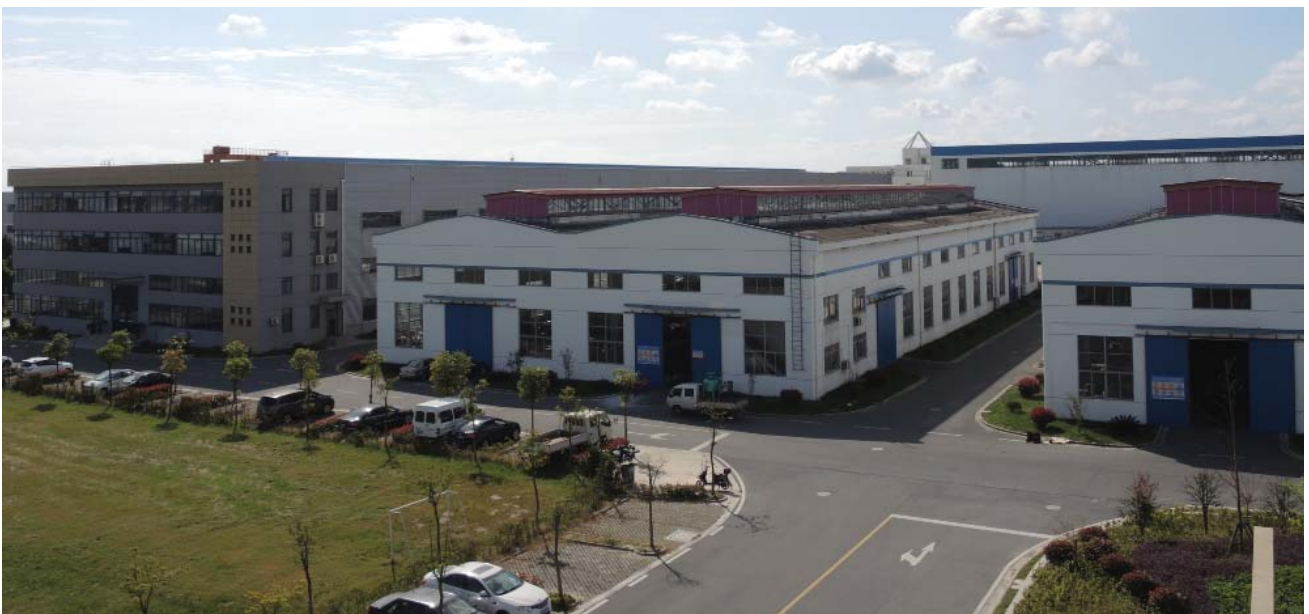
上海良时车间远景(新工厂总占地面积57000平方米，老工厂总占地面积5000平方米，车间占地面积30000平方米，办公楼面积3000平方米，研发中心面积2000平方米)
